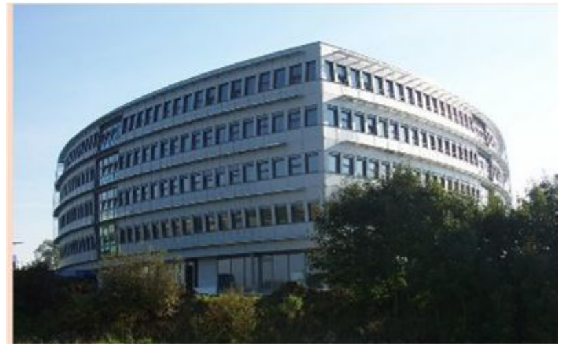
EnerCom Ulm, Atriumhaus . Oehler + arch.kom Foto: Oehler
