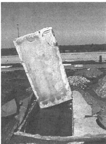
Bild 28. Freilegung einer XPS-Dämmstoffplatte in einem Gründach
